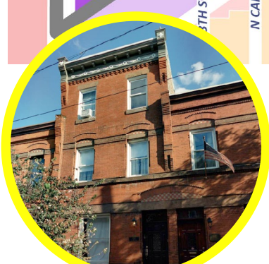
Viviendas adosadas en terrenos individuales
