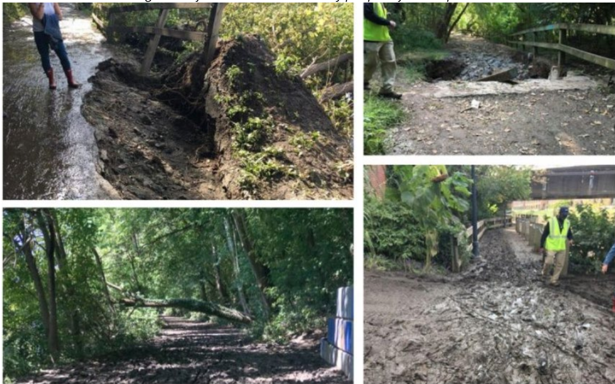
Figura 3: Infraestructura de senderos y parques afectados por Ida
