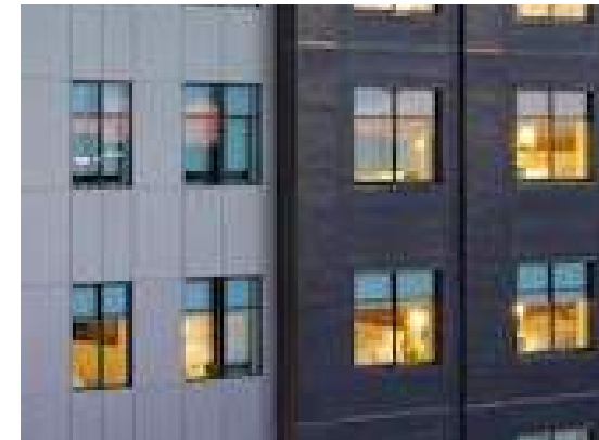
4 Metal Clad Windows
