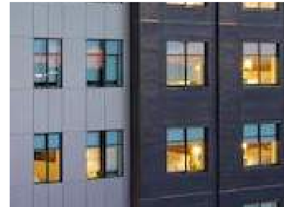
4 Metal Clad Windows
