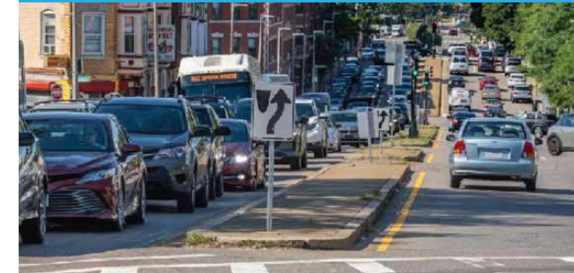
B) Concrete Median | Mediana de concreto
