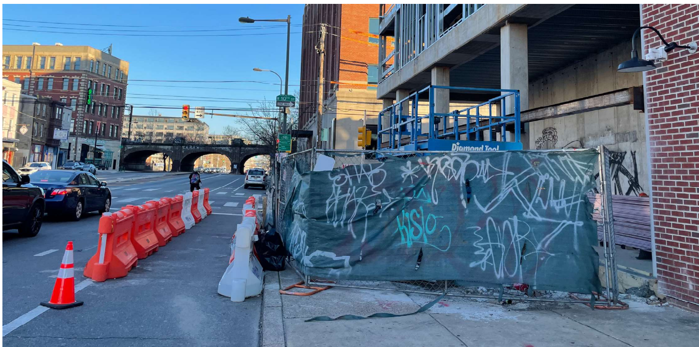
Cierre de acera debido a obras en la esquina de Spring Garden y 10th Street, en dirección este. Fuente: Sojourner Consulting
